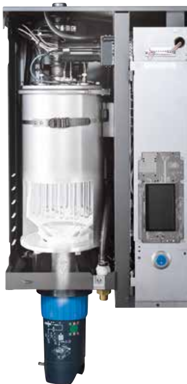
Le calcaire est évacué hors de l'appareil vers le récupérateur de calcaire
