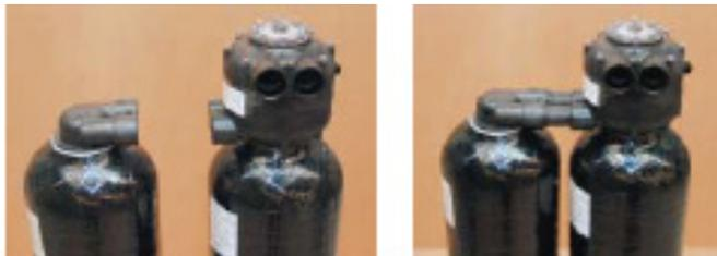
3. Placez les joints toriques sur les pièces de raccordement en plastique noir et laiton. Lubrifiez avec du silicone à l'aide du petit tube. Ensuite, installez les pièces de raccordement illustrées sur les photos ci-dessous.
