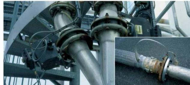
Photo 2. Shunts électriques assurant la continuité électrostatique d'une canalisation dans laquelle circule un solvant.
