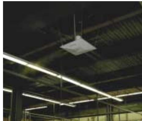
Des buses haute pression spéciales atomisent l'eau en un brouillard d'aérosol ultrafin. Le système *TurboFog 32* de *DRAABE* est spécialement conçu pour les grands bâtiments
