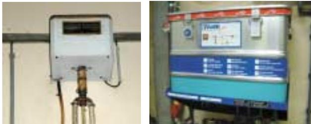
Les humidificateurs à vapeur (à gauche) ont été mis hors service. Le système à pulsation haute pression (à droite) est intégré dans un petit conteneur portable, qui peut être remplacé en un tour de main pour la maintenance.
